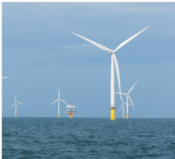
アラップは洋上風力発電基礎(OWF)の技術設計に関する、豊富な実績を有しています。浮体式洋上基礎や係留施設に加え、モノパイル、ジャケット、自律設置型重力式基礎などの着床式基礎の設計業務にも携わってきました。またプロジェクトの敷地選定から環境計画、詳細設計および撤去・解体まで、構造物全体のライフサイクルを網羅した業務経験も有しています。
