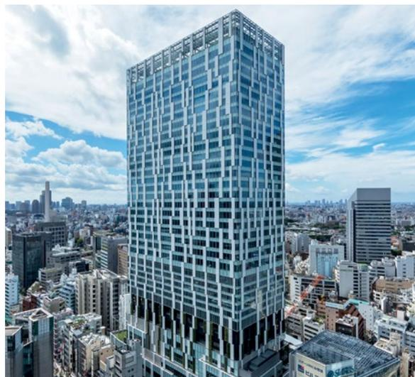
本プロジェクトは渋谷駅周辺の再開発計画の一つであり、高さ約180mの超高層ビルを中心に渋谷ストリームホール、アーバンコア、駅へと繋がる連絡橋等で構成されています。ランダムに配置された白いパネルが、単調になりがちな超高層ビルのファサードに表情をつくり出し、パネル部の縦型スリットから取り入れた外気を天井内のナイトパーージや設備の給気に利用しています。
